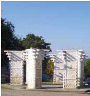
Peter HENZES Betonwasserkunst
